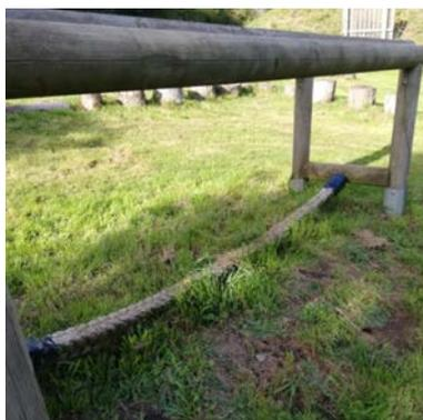
Der Querbalken der Schaukel ist instabil und wird ausgewechselt und die Nestschaukel anschließend wieder angebaut; Schaukel ggf. mit Holzschutzmittel bearbeiten wg. längerer Haltbarkeit.
