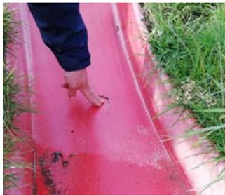
Hangrutsche: Es sind Löcher im Rutschenauslauf, an denen man hängenbleiben bzw. sich die Kleidung aufreißen kann. Unter diesem Teil der Rutsche scheint ein Hohlraum zu sein. Es ist zu überprüfen, ob ein Ersatzteil für den Rutschenauslauf beschafft werden kann oder ob Rutsche repariert werden
