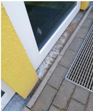
An den Eingangspodesten zum KiTa-Anbau sind durch die Pflasterung der Podeste Fußfangstellen entstanden. Es ist amtsseitig zu prüfen, welche Änderungsmöglichkeiten bestehen, auch unter dem Aspekt von Barrierefreiheit (Podest ggf. abbauen und als Rampe umbauen o.ä.). Der ausführende Architekt wird erneut eingeschaltet, Thomas Stengel (Vorsitz Bauausschuss) wird beauftragt sich um die Angelegenheit zu kümmern.
